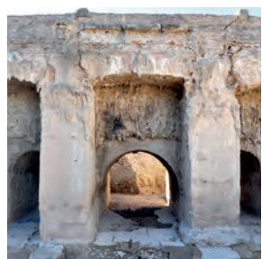
35 Acueducto Rambla de las Zorreras
