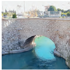
34 Puente de las Pilas
